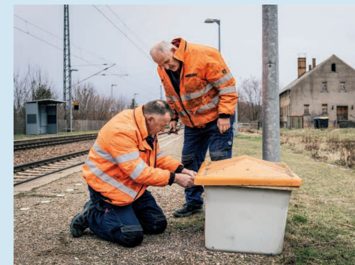
Provisorische Lösung: Kreideweiß befestigt den Deckel des Streugutbehälters in Stauchitz vorerst mit Kabelbinder
