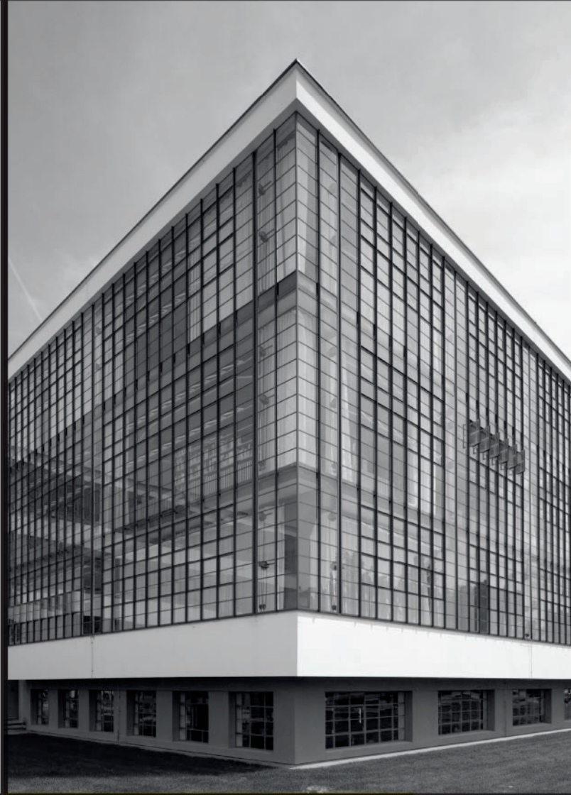
Das Bauhaus-Gebäude in Dessau (oben, 1925–26) wurde von Walter Gropius entworfen. Die vor das tragende Skelett gehängte Glasfassade war revolutionär. Der Isokon Long Chair von Marcel Breuer (r.) ist ein Klassiker
